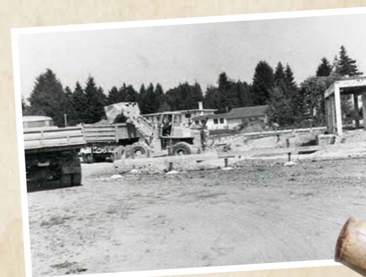
Baubeginn des Hallenbades
