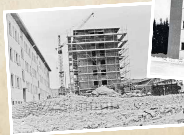
Baustelle Neuer Platz
