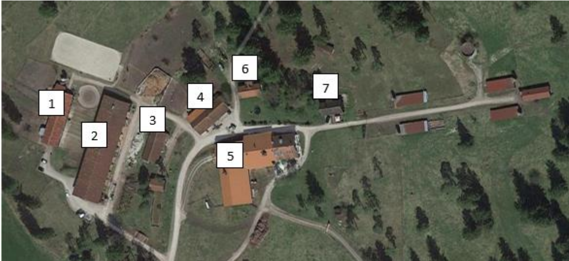
Abbildung 5-5: Übersicht Gebäude Gut Buchberg.
