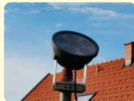
Kirchenbeleuchtung Gelting. Fotoquelle: Stadt Geretsried
