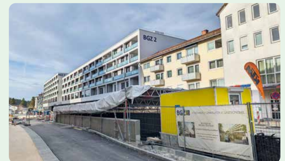
Fast fertig: das neue BGZ2 in der Egerlandstraße. Fotoquelle: Stadt Geretsried
