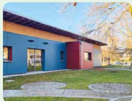
Bald zweistöckig: die Mittagsbetreuung an der Karl-Lederer-Grundschule. Kostenpunkt: ca. 2,7 Mio Euro. Fotoquelle: Stadt Geretsried
