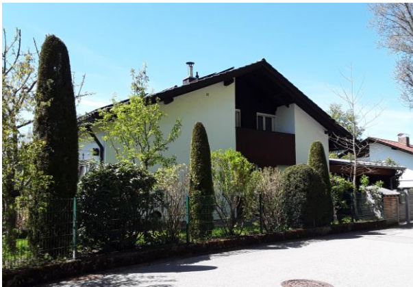
Abbildung 11: Gebietstypisches Erscheinungsbild, Isardamm 11 (Quelle: eigene Aufnahme PV).
