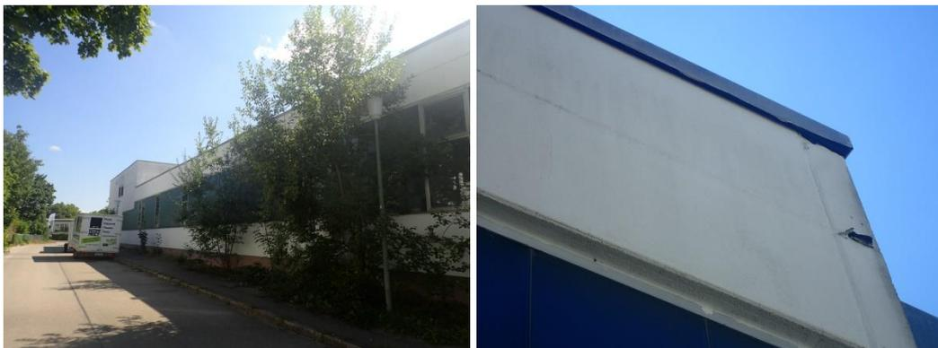
Abbildung 4: Gebäude Bunsenweg 9 (li) und Dach mit Versatz zur Fassade (re). Quelle: PV am 30.08.2022.
