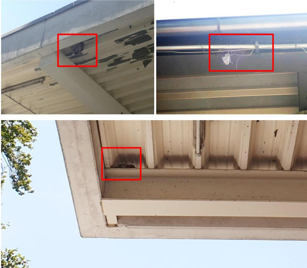
Abbildung 6: Wespennest (oben links) und Vogelnest (oben rechts und unten) an der Stahlkonstruktion vom Bunsenweg 9. Quelle: PV am 30.08.2022.
