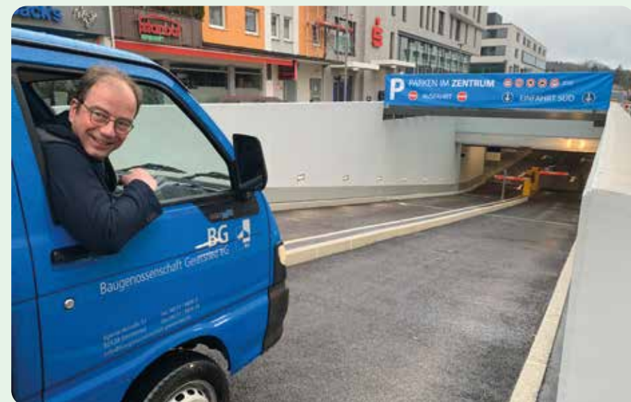
Bequem von allen Seiten erreichbar: die neue Zentralgarage in der Neuen Mitte. Fotoquelle: Stadt Geretsried
