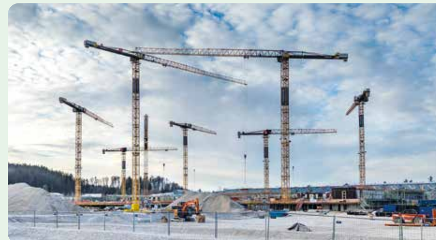
Läuft auf Hochtouren: die Baustelle von OPUS.G an der Banater Straße. Fotoquelle: Stadt Geretsried
