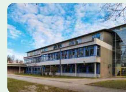
Das nächste große Bauprojekt: die Sanierung der Adalbert-Stifter-Mittelschule Fotoquelle: Stadt Geretsried
