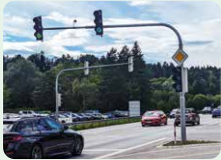
Rundum erneuert: Fundament und Ampel an der B11-Ausfahrt Geretsried-Mitte. Fotoquelle: Stadt Geretsried
