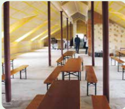
Wurde komplett erneuert: der Dachstuhl des Rathaus-Nebenflügels. Fotoquelle: Stadt Geretsried
